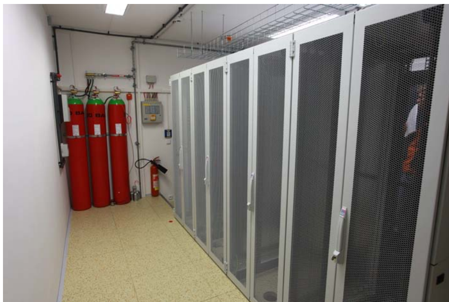
Obrázek 5: SHZ na serverovně UI420.
